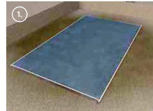
1. Couler la dalle en béton avec Treillage métal 8/8/150/150
